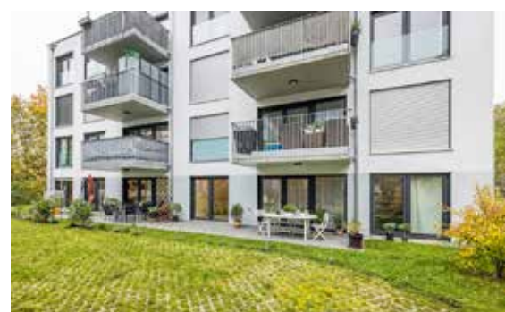
Die Wohngemeinschaft im Erdgeschoss, Erich-Bloch-Weg
